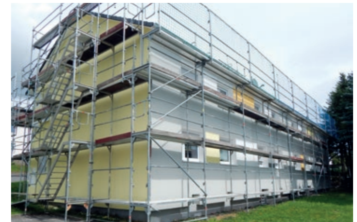
ENERGETISCHE SANIERUNG Kremelstr 17-23 · Baumholder (vorher/während/nachher)
