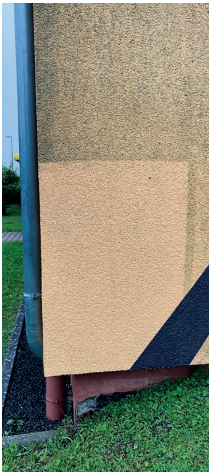
FASSADENREINIGUNG Am Pulverturm 1 · Birkenfeld
